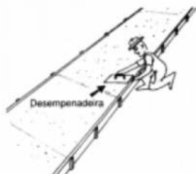
Figura 3 – Acabamento da calçada
