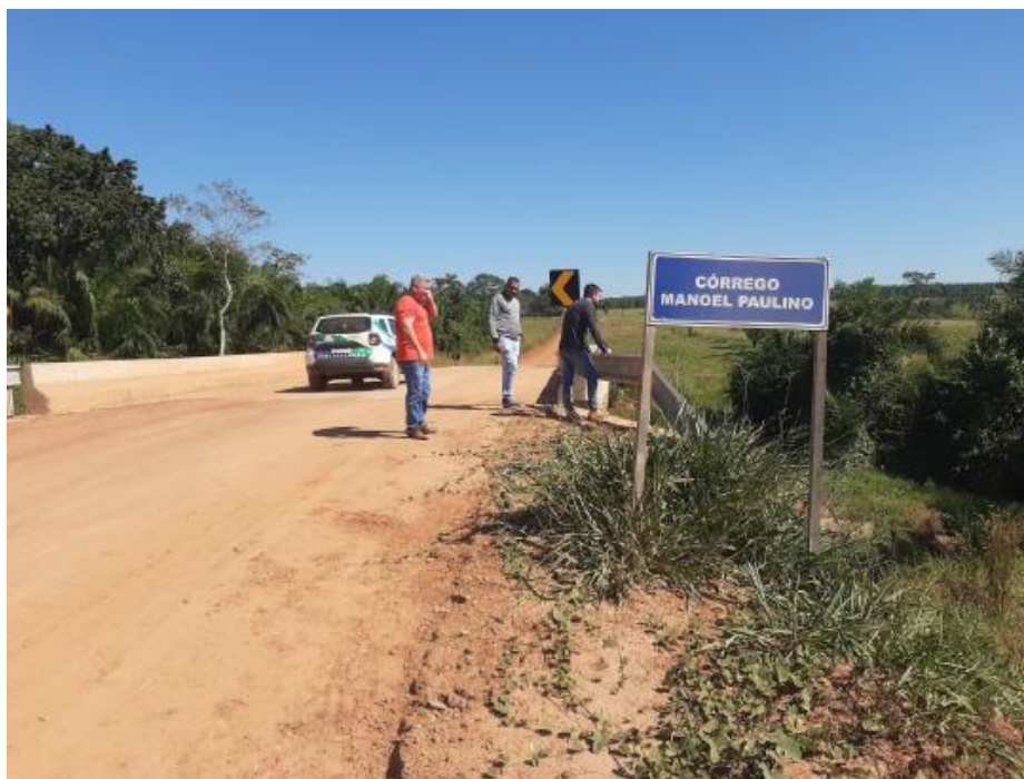
PONTE DE CONCRETO FINALIZADA – CÓRREGO MANOEL PAULINO – SÃO JOSÉ DOS QUATRO MARCOS – MT – DATA: 29/05/2024
