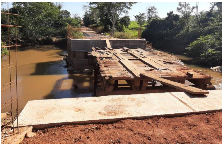
PONTE DE CONCRETO EM EXECUÇÃO – RIO BUGRES – DISTRITO DE SANTA FÉ SÃO JOSÉ DOS QUATRO MARCOS – MT – DATA: 29/05/2024
