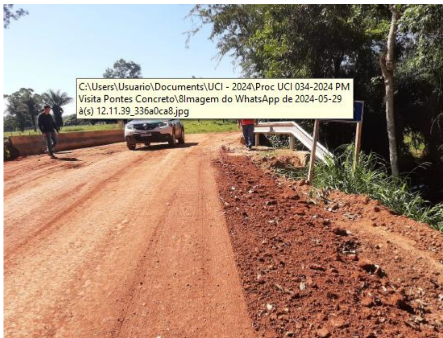
PONTE DE CONCRETO FINALIZADA – CÔRREGO DA SALVAÇÃO – SÃO JOSÉ DOS QUATRO MARCOS – MT – DATA: 29/05/2024
