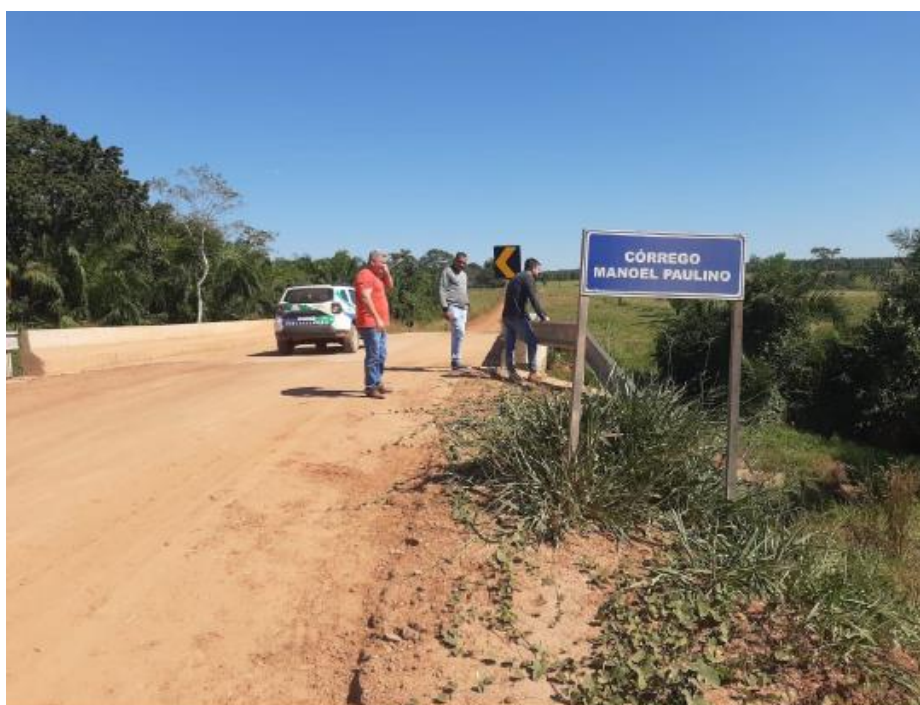
PONTE DE CONCRETO FINALIZADA – CÔRREGO MANOEL PAULINO – SÃO JOSÉ DOS QUATRO MARCOS – MT – DATA: 29/05/2024
