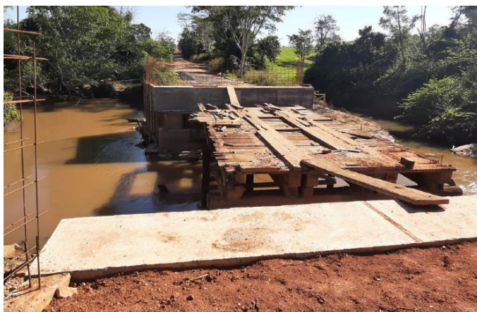
PONTE DE CONCRETO EM EXECUÇÃO – RIO BUGRES – DISTRITO DE SANTA FÉ – SÃO JOSÉ DOS QUATRO MARCOS – MT – DATA: 29/05/2024
